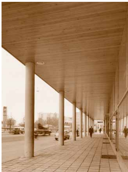
Pylväskäytävä kannattelee konserttisalia. SIREN ARKKITEHDIT OY, KUVA-ARKISTO.
