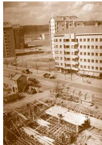
Konserttitalo rakenteilla v. 1954.
